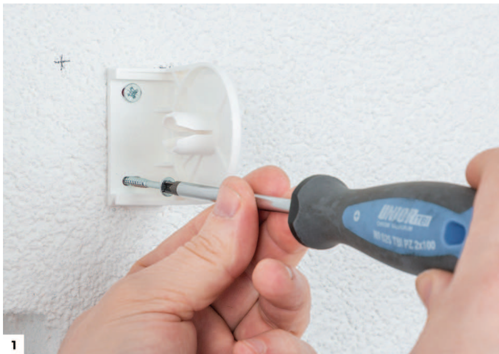
Slika 1: Nosilec z izbočenim sredinskim delom skozi obe odprtini privijačite na podlago.
