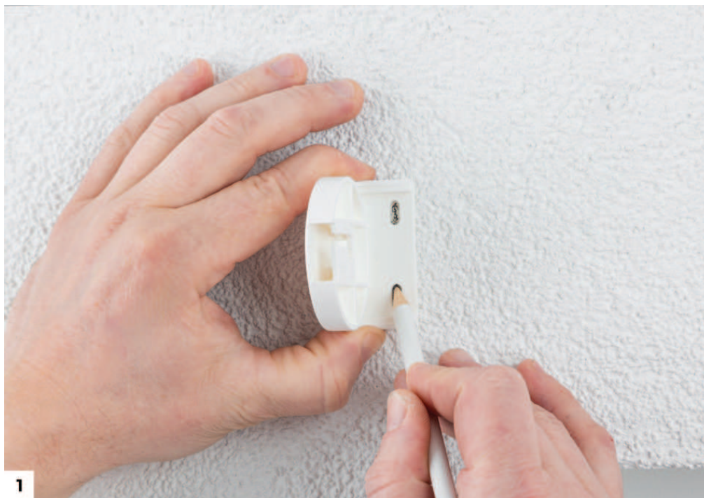
Slika 1: Zunanjo stranico drugega nosilca poravnajte na izmerjeno višino in označite luknji za vijačenje.
