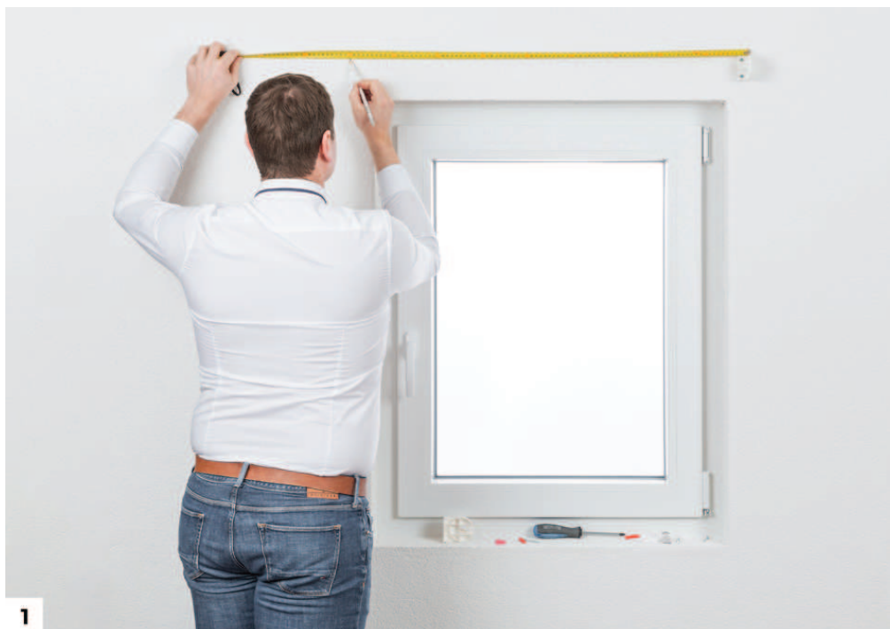
Slika 1: Od privijačenega nosilca odmerite dolžino roloja. Merite od zunanje stranice nosilca.
